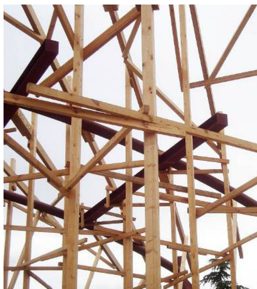
Paraboloide hiperbólico que sirvió de base para obtener la geometría de la cubierta de madera resuelta con listones rectos (gentileza de la empresa Cammi)
