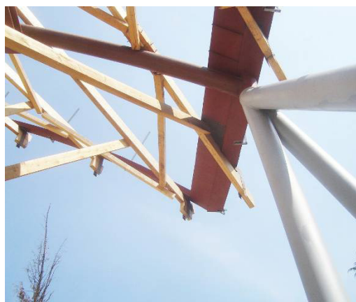
Modelo de la cubierta de madera funcionando como carcasa (gentileza de la empresa Cammi)
