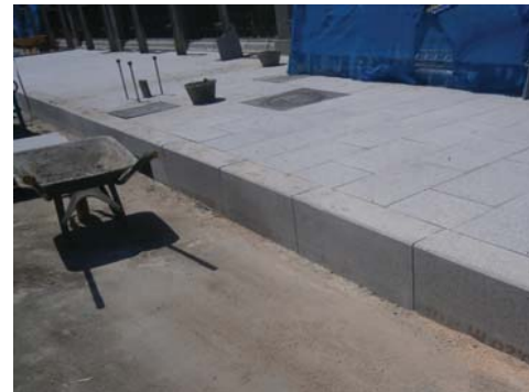
Estado del pavimento y de las aceras previo a las obras, con ancho de paso útil para peatones del orden de 80 cm
