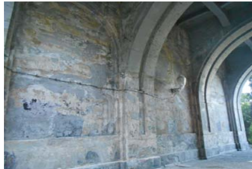
Estado de los muros anterior y posterior a la aplicación de la pintura anticarbonatación.
