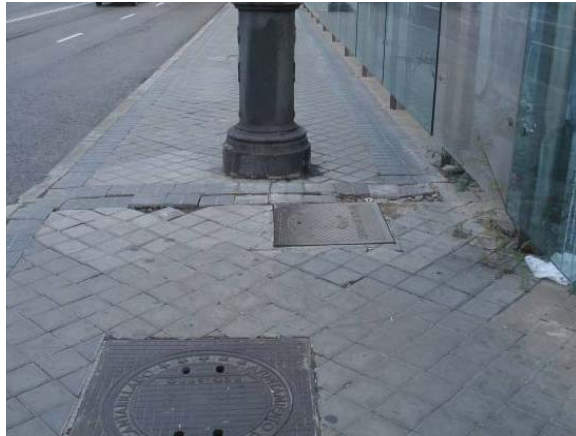
Estado del pavimento y de las aceras previo a las obras, con ancho de paso útil para peatones del orden de 80 cm
