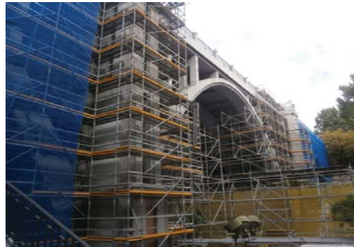
Andamiaje para las obras de reparación.
