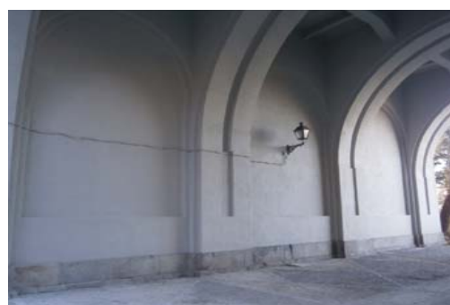
Estado de los muros anterior y posterior a la aplicación de la pintura anticarbonatación.
