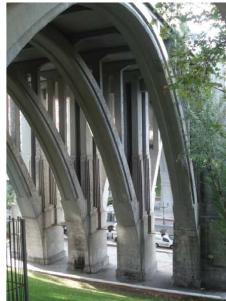
Alzado de los fustes del vano nº 3 antes de las obras.
