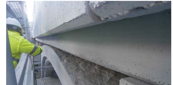
Aplicación de pintura anticarbonatación.
