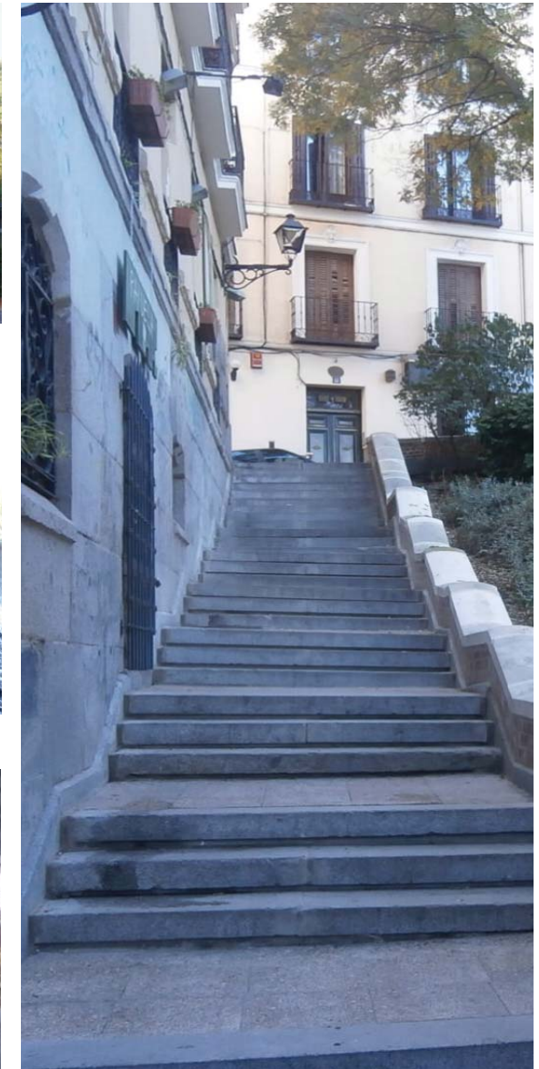
Reparación de las zonas estanciales.
