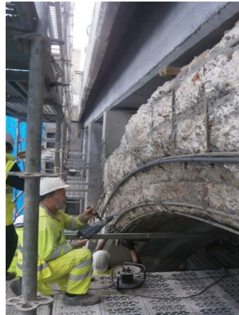
Proceso de las obras de regeneración estructural.
