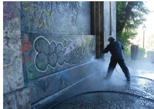
Limpieza de los muros con chorro de silicato de aluminio y agua a presión.
