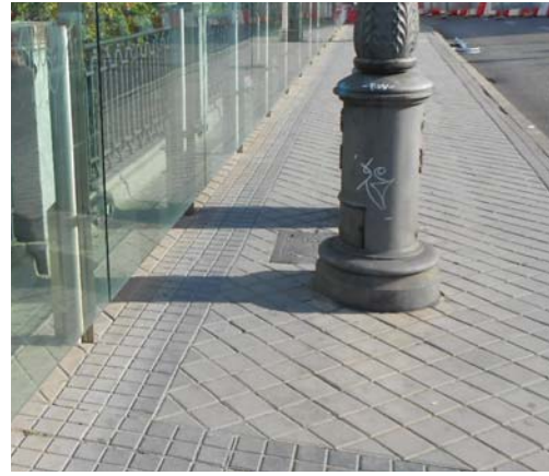
Estado del pavimento y de las aceras previo a las obras, con ancho de paso útil para peatones del orden de 80 cm
