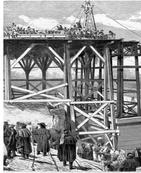
Construcción original del viaducto en hierro.
