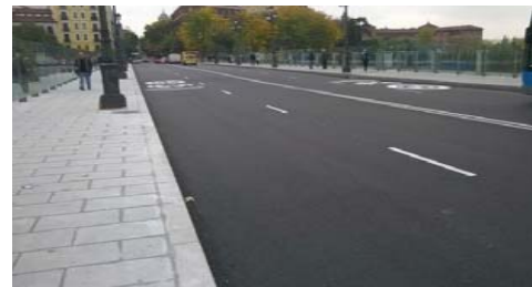
Estado del pavimento y de las aceras tras la intervención, con ancho libre de 1,80m
