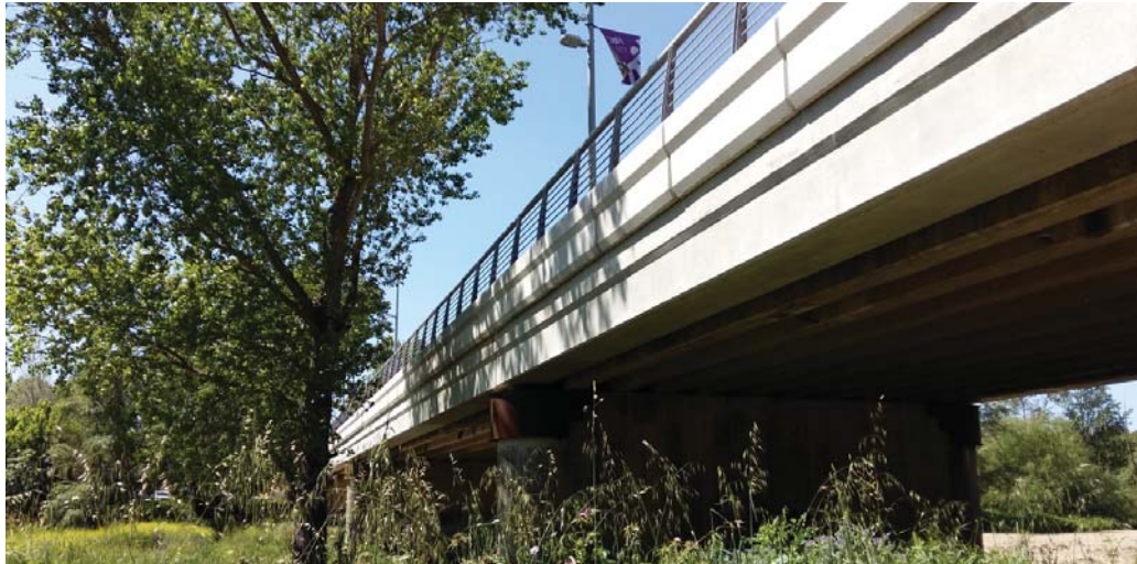
Vista de la obra
