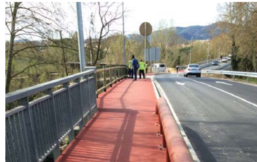
Pretil tubular metálico
