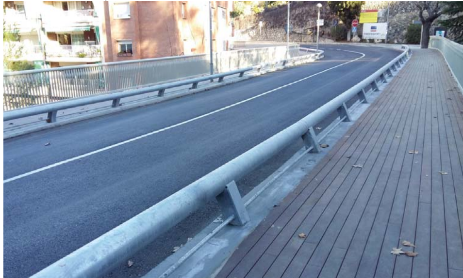
Carretera y acera sobre puente.
