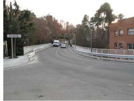
Vista del puente (estado previo).
