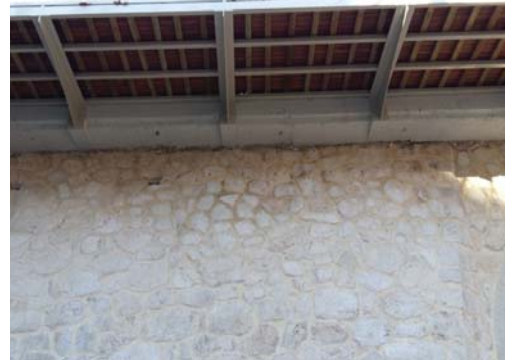
Vista inferior del puente.
