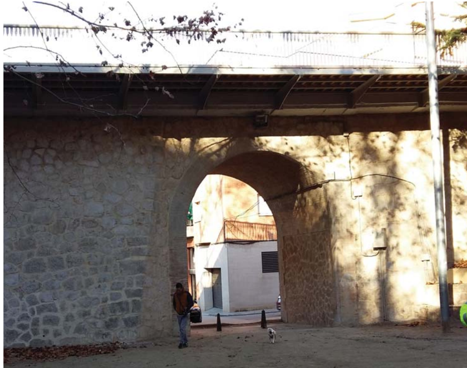
Vista lateral del puente.
