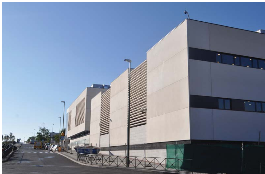
Fachada calle Azul.
