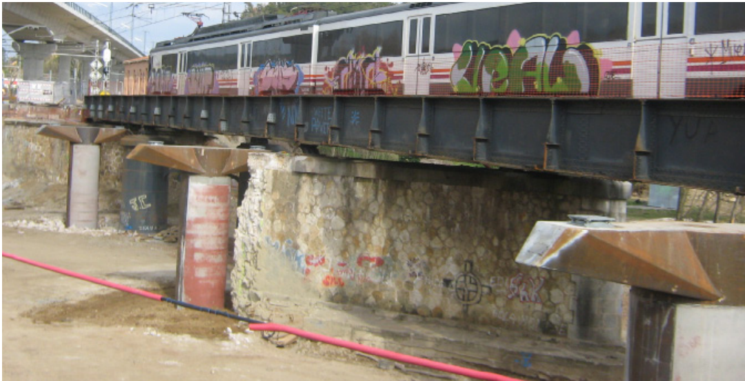
Proceso de construcción del puente: renovación del primer tablero
