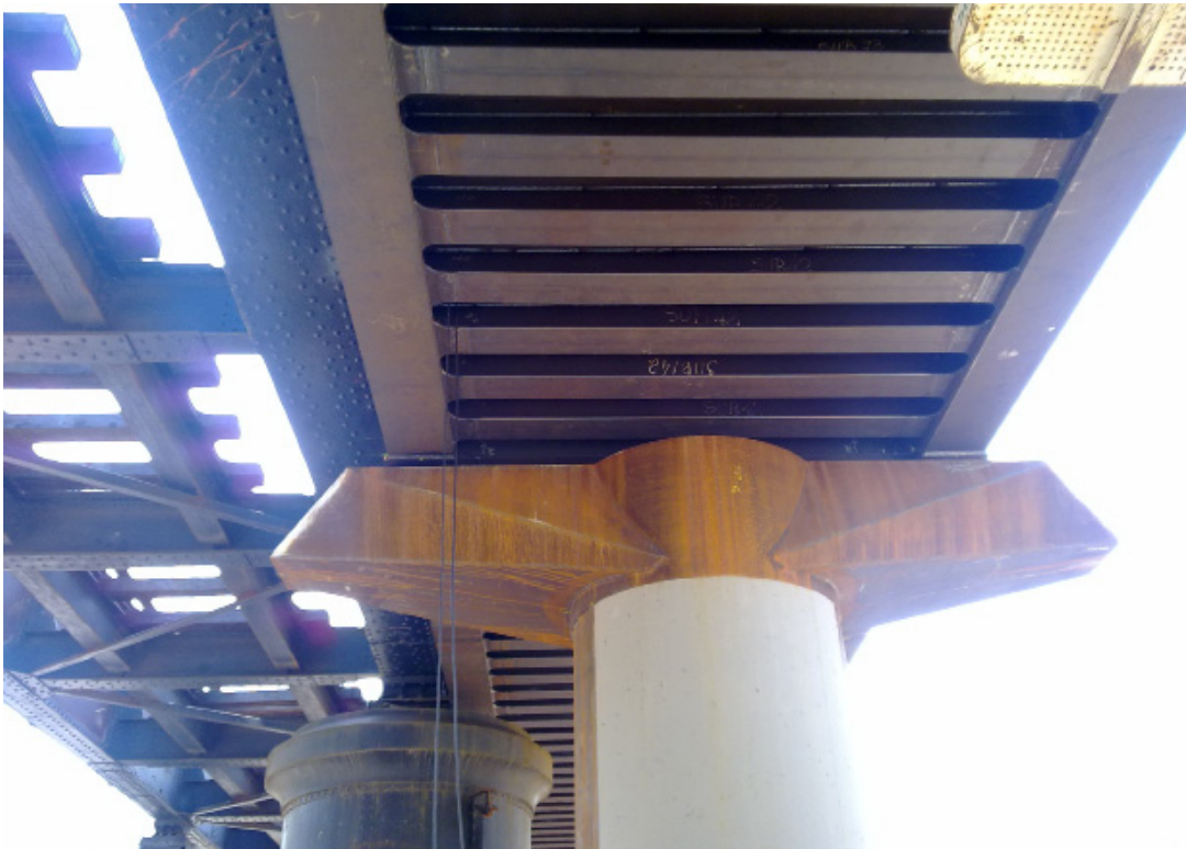
Proceso de construcción del puente: mitad del tablero renovado
