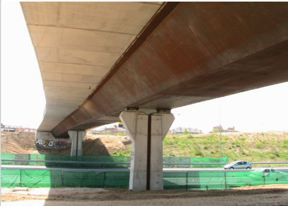
Vista final del puente construido
