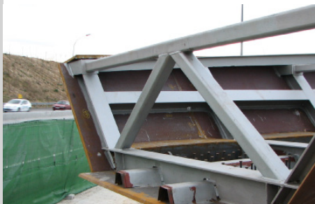
Proceso de construcción
