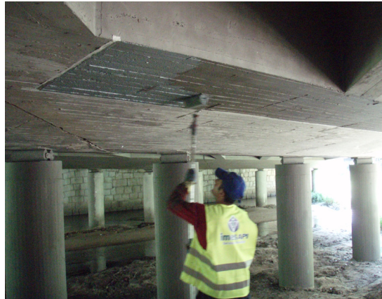
Proceso de intervención
