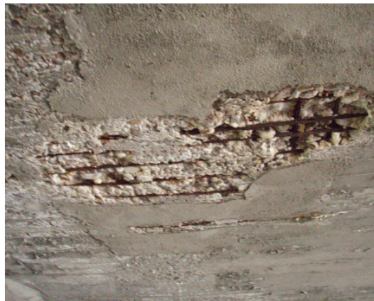
Antes de la intervención
