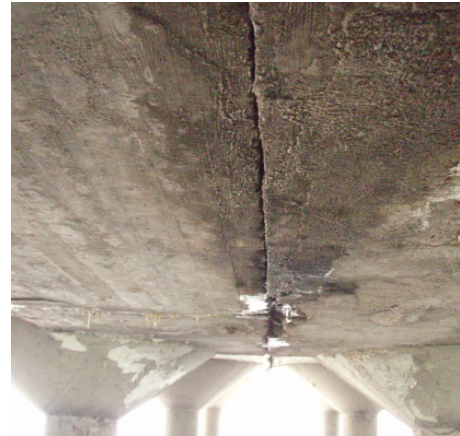
Antes de la intervención
