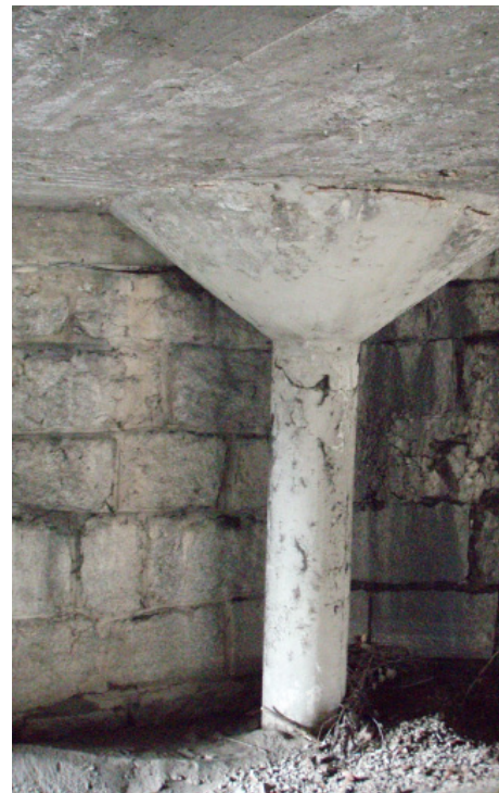
Antes de la intervención
