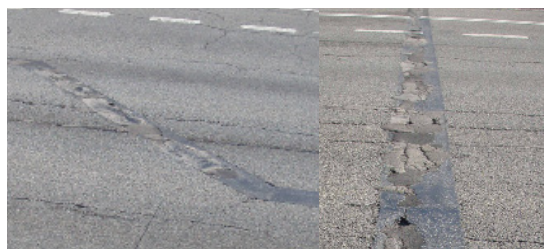
Antes de la intervención
