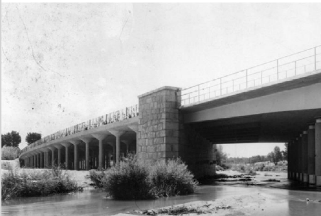
Palizada de acceso a la izquierda y puente de vigas sobre el cauce a la derecha
