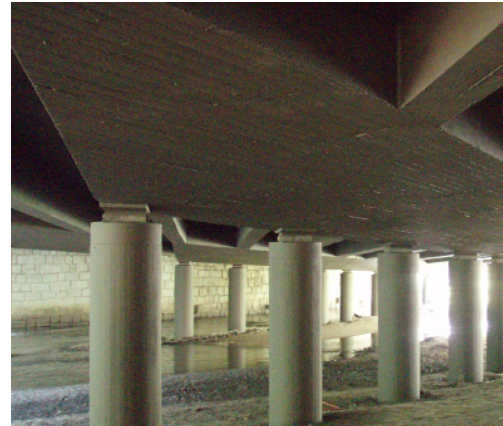
Proceso de intervención
