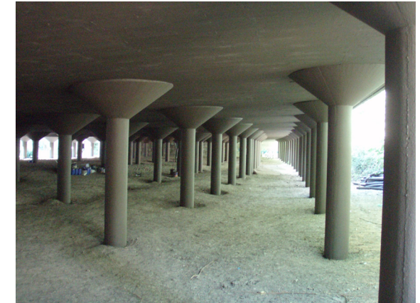
Proceso de intervención
