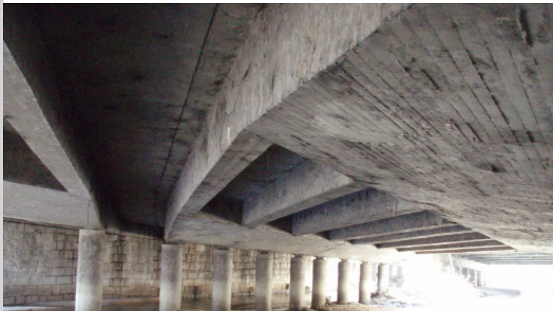
Vista inferior de la estructura de vigas del puente sobre el cauce del río Manzanares
